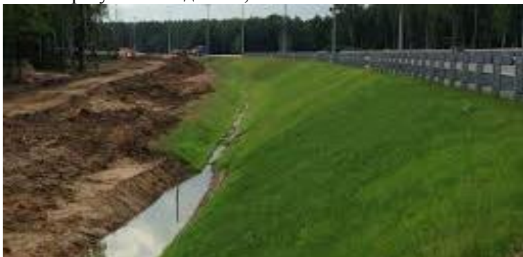
Рис. 1. Укрепление насыпи засевом трав
