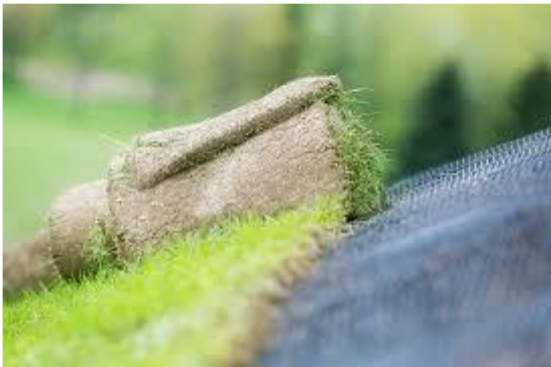
Рис. 2. Укрепление откосов одерновкой
