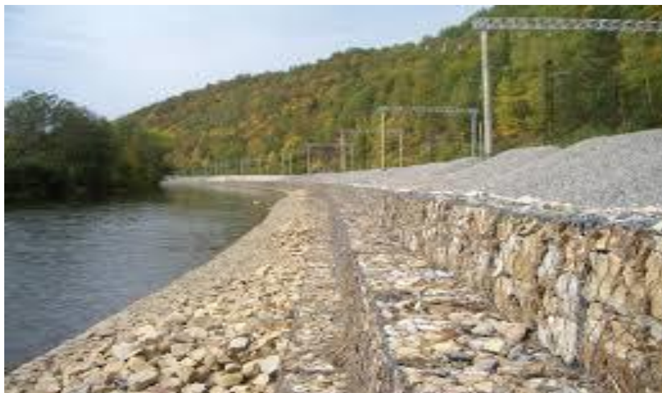
Рис. 3. Укрепление каменной наброской
