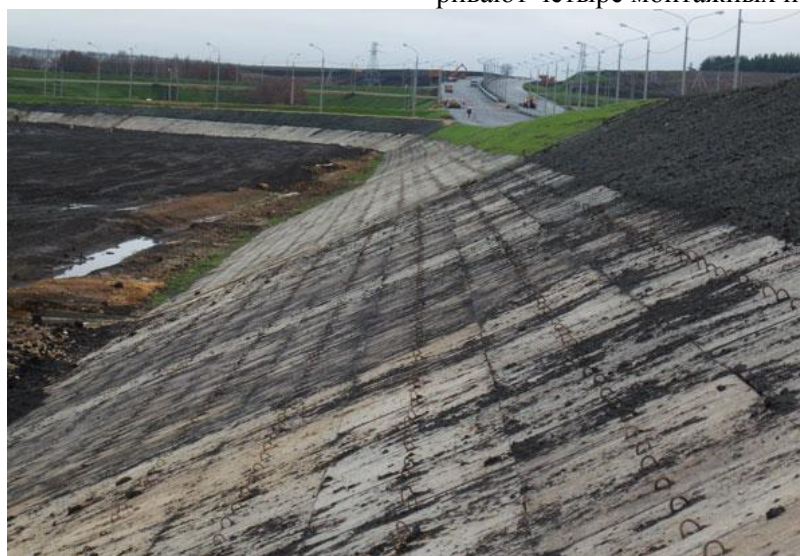
Рис. 4. Укрепление насыпи бетонными плитами
